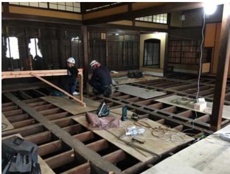
2階床下の補強
