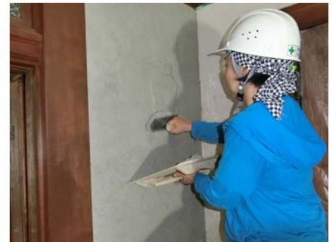
耐力壁の壁塗り
