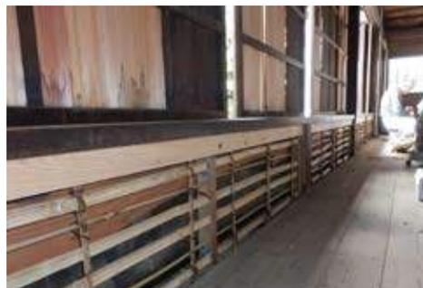
上：工事前の2階北廊下敷居が太鼓橋のように水平垂直方向にたわんでいた。（白い点線はイメージ）
